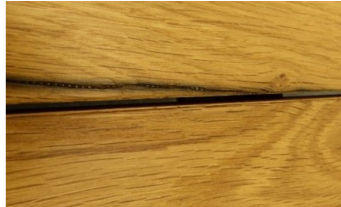
Die Mutation von Holz im Laufe der Jahre verändert dieses natürliche Material und bildet Risse und Schnittwunden. La mutation du bois au fil des ans modifie ce matériau naturel, formant des fissures et des déchirures.
